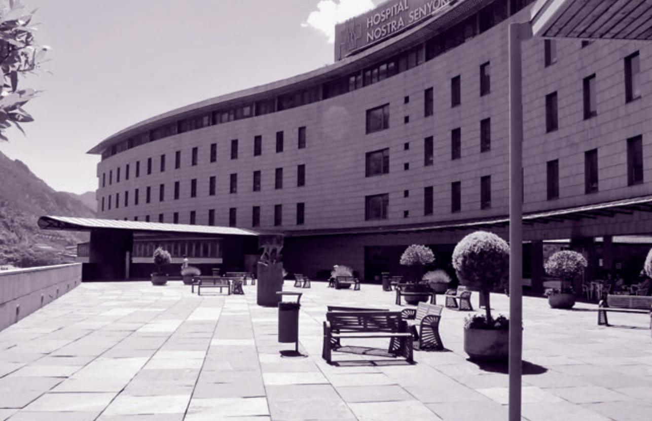
Actual Hospital Nostra Senyora de Meritxell, a Escaldes-Engordany. Foto: HNSM.
