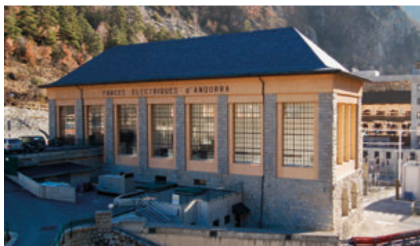
Foto 9. Edifici de FEDA (Forces Elèctriques d'Andorra), antiga FHASA. © Fons del Dept. de Patrimoni Cultural d'Andorra, Govern d'Andorra.
