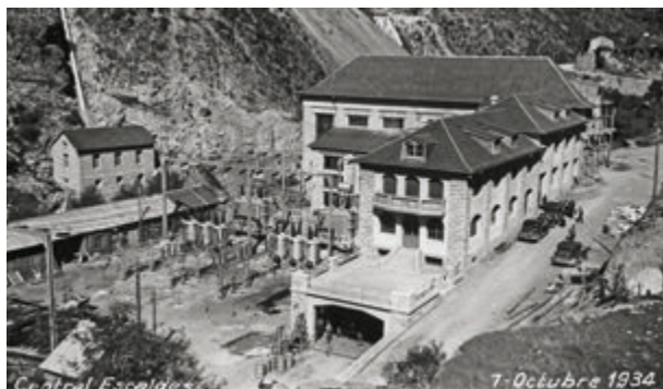
Foto 8. Edifici de l'antiga FHASA. © Fons FEDA, imatge 5 (1) FEDA-0174-35 del MW Museu de l'Electricitat.
